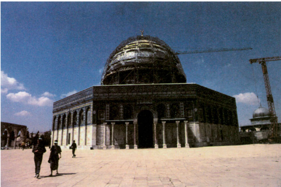
Εικ. 1.10: Το τέμενος του Ομάρ στην Ιερουσαλήμ σε φάση εργασιών επισκευής που αποσκοπούν στην προστασία του μνημείου
