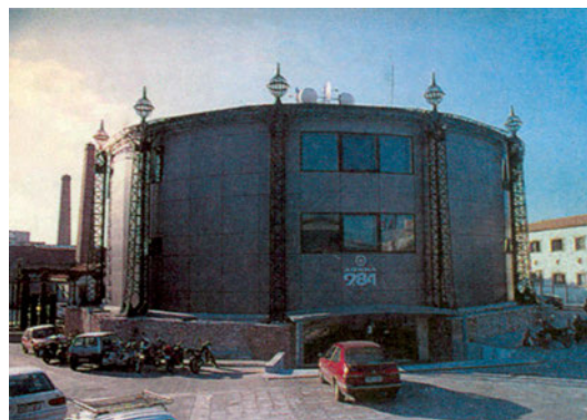
Εικ. 7.29: Άποψη του "Γκαζιού". Το κτίριο (πρώην δεξαμενή) στεγάζει σήμερα το ραδιοφωνικό σταθμό 9,84 του Δήμου Αθηναίων.
