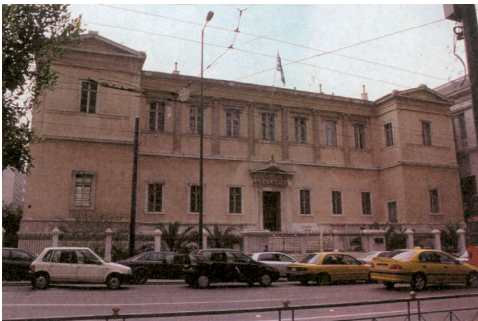
Εικ. 7.1: Το κτίριο του Αρσάκειου, έργο του αρχιτέκτονα Α. Καυταντζόγλου του 19ου αι., μετά τη μετατροπή του σε έδρα του Συμβουλίου της Επικρατείας
