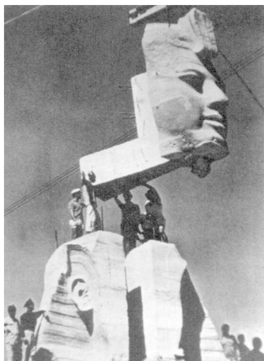
Εικ.5.12: Τμήμα τον αγάλματος του φαράώ από το ναό του Ραμσή στο Αμπού Σιμπέλ κατά τη φάση της συναρμολόγησης
