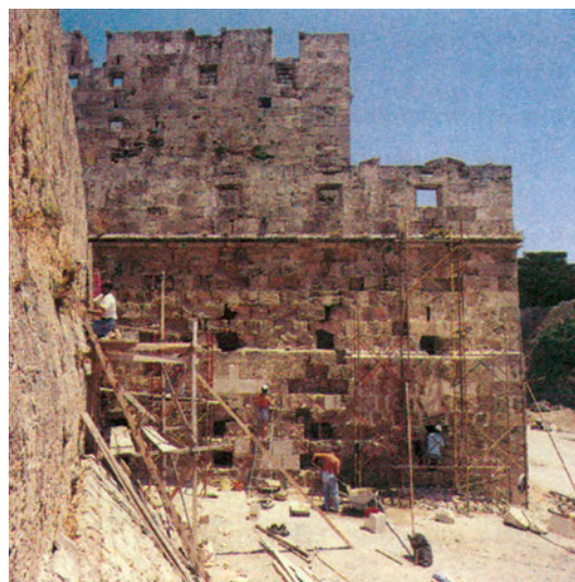
Εικ. 7.15: Επιφανειακή επισκευή τμήματος του τείχους της μεσαιωνικής πόλης της Ρόδου, που είχε εμφανίσει έντονα προβλήματα διάβρωσης
