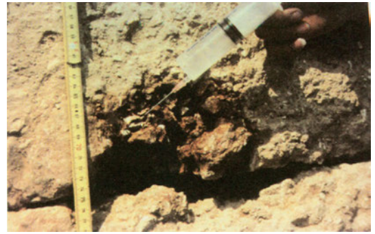
Εικ.1.17: Στερέωση λίθου τοιχοποιίας
