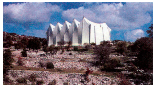
Εικ. 6.25: Σημερινή άποψη του ναού του Επικούριου Απόλλωνα στις Βάσσεις μετά την κάλυψή του από στέγαστρο
