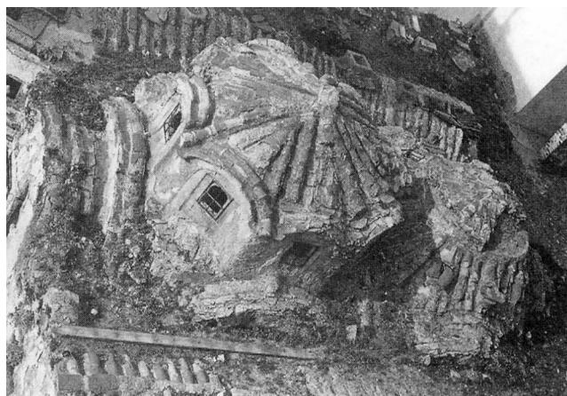
Εικ. 6.35: Άποψη βυζαντινού λουτρού στη Θεσσαλονίκη
