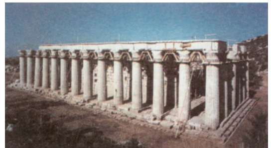
Εικ. 6.24: Ο ναός του Επικούριου Απόλλωνα στις Βάσσεις μετά τις πρόσφατες αντισεισμικές και αντικεραυνικές κατασκευές (1984 - 1986).
