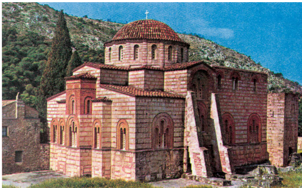
Εικ.6.42: Βορειοανατολική άποψη του Καθολικού της Μονής Δαφνιού. Διακρίνονται οι αντηρίδες στη βόρεια πλευρά.
